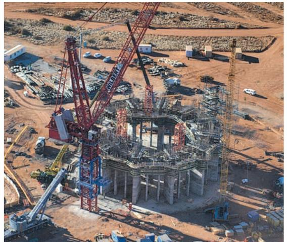
*Arriba:* IFC respalda la construcción de las primeras plantas de energía solar concentrada de Sudáfrica, en las que se utilizarán espejos que reflejan y concentran la luz solar para calentar el vapor que alimenta las turbinas.
