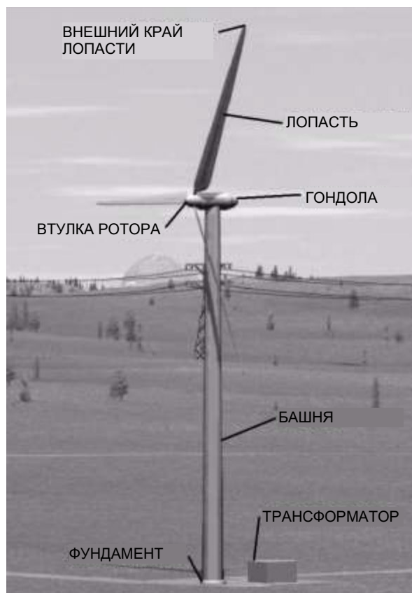
Рисунок А-2: Типичные конструктивные элементы ветровой турбины
